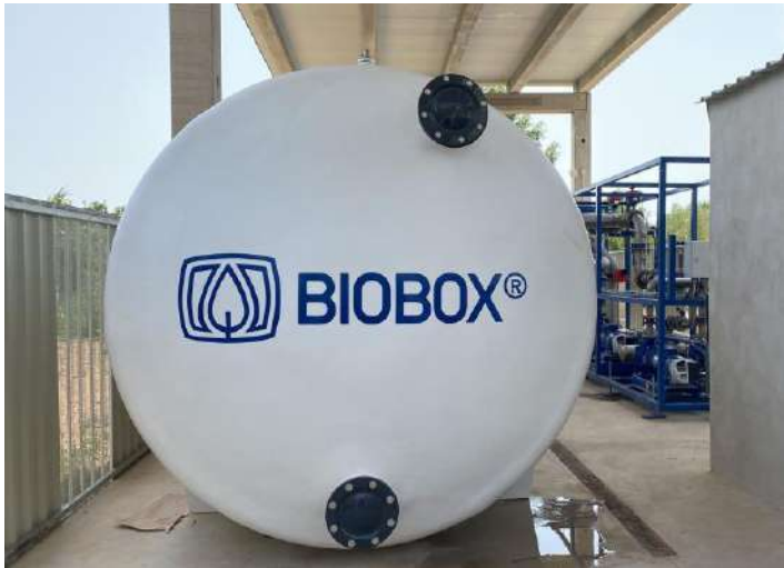
Figura 1: Planta de Biofiltración BIOBOX Nitratos 120 m 3 /h (Recirculación, suministro 200 m 3 /h)
